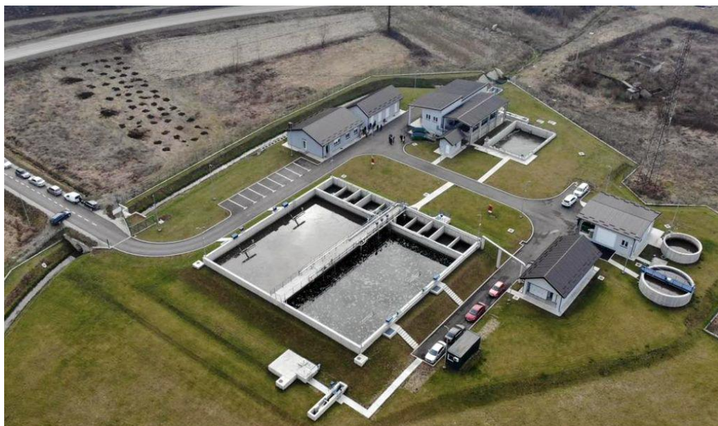
Postrojenje za preradu otpadnih voda u Tesliću
